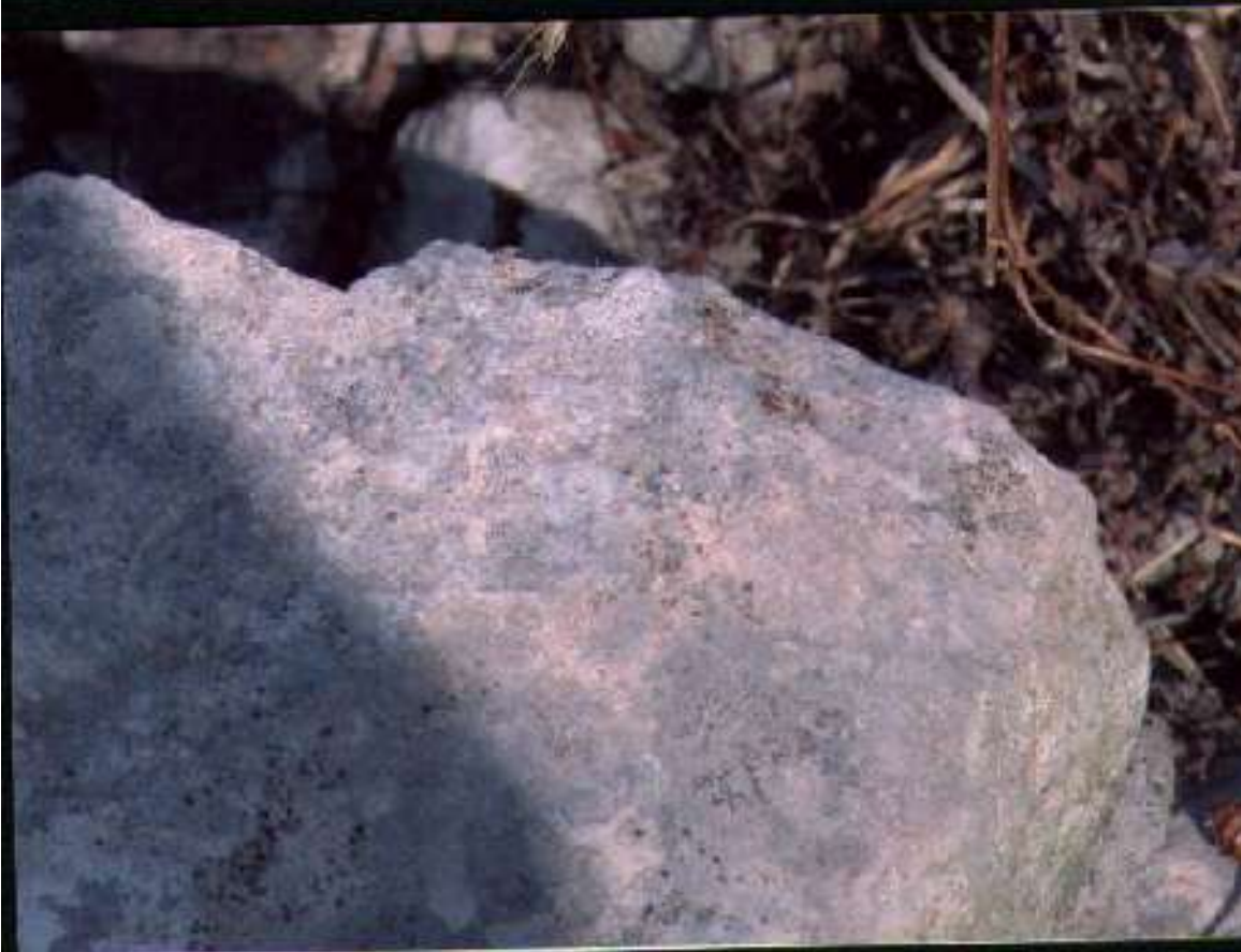
Branda lastre di copertura dei loculi
