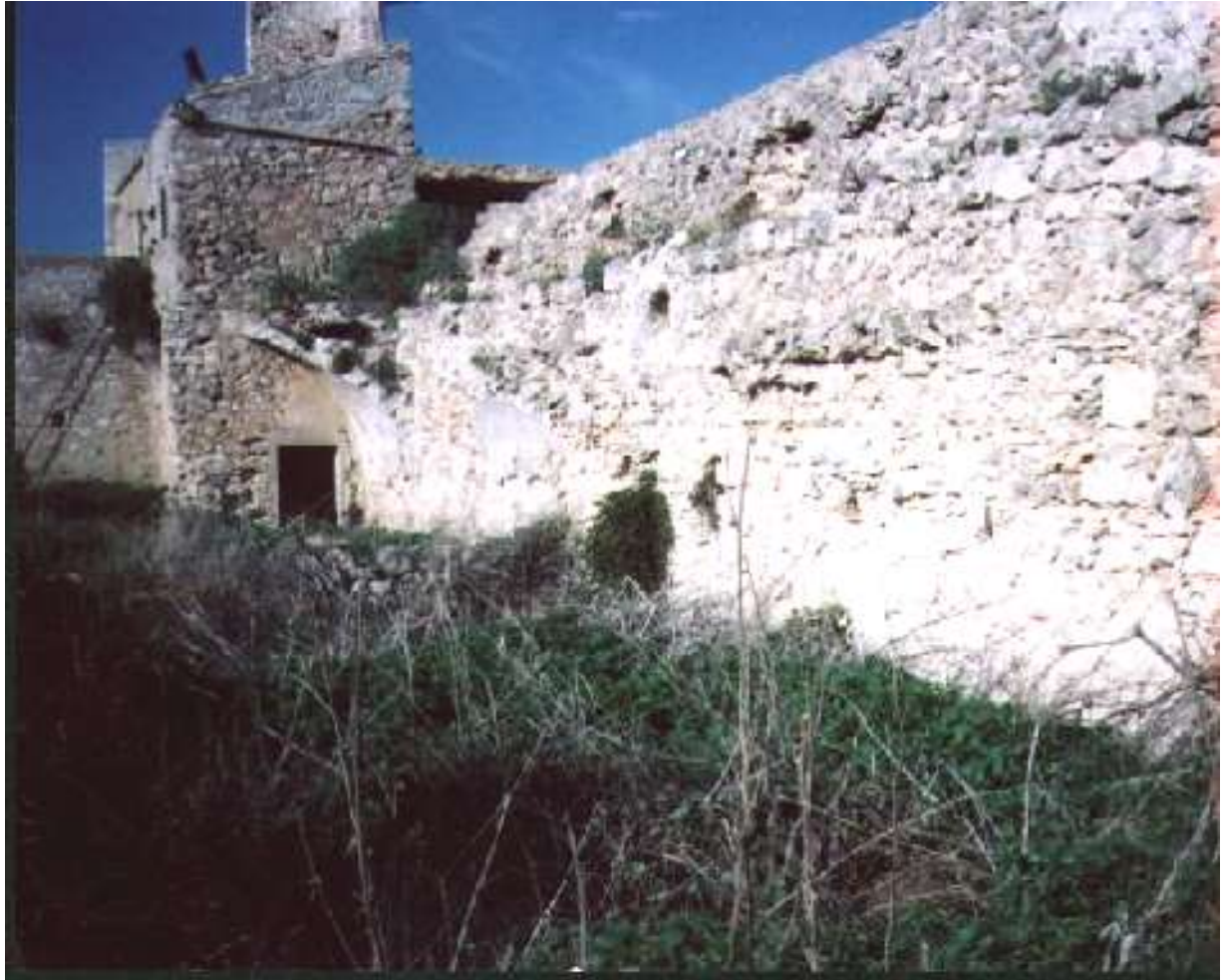
Muro interno edificio Serralonga.
