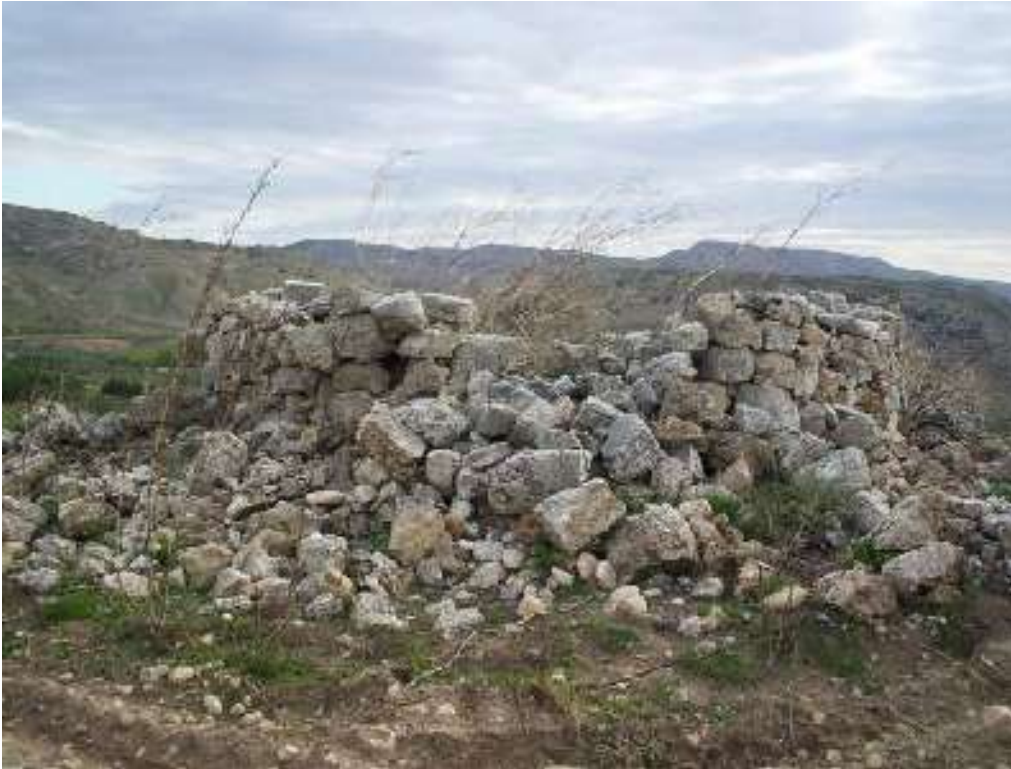
Cupuluni 7 Torre Salsa esterno nord-ovest. Crollato da qualche decennio.
