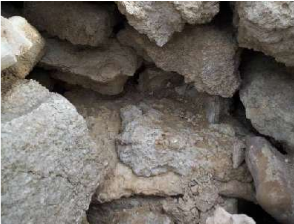
Cupuluni 7 Torre Salsa particolare muro interno da notare la costruzione a secco.
